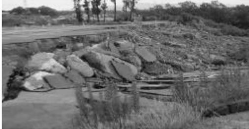
Fig.3 C 材盛土法面の崩壊状況
